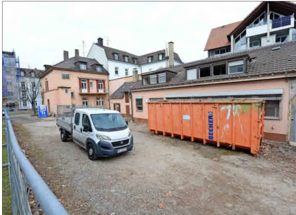
Im Hintergrund das historische Haus in der Habsburgerstraße 91, daneben das aufgestockte weiße Gebäude Habsburgerstraße 89, in dem einst eine Sparkassen-Filiale war.
